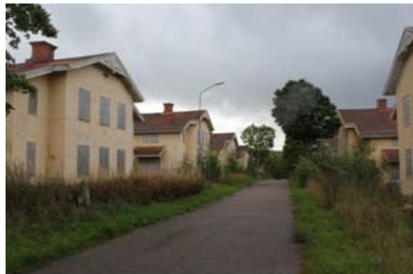
写真3 ゴーストタウン化したシェールファレット住宅地
