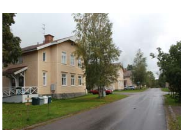
写真4 住民によって良好に維持管理されているストーラーハーゲン住宅地
